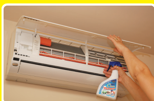
4. Ψεκάστε τα στοιχεία-κυψέλες του Air Condition που βρίσκονται πίσω από τα φίλτρα.
