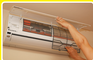
1. Αφαιρέστε τα φίλτρα του Air Condition.
